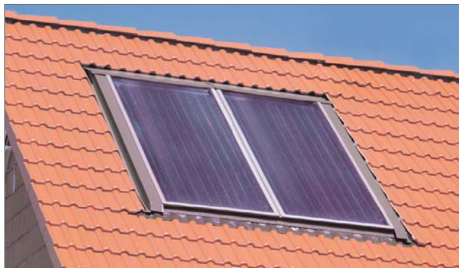
Рис. 3-10 Вид готового монтажа в крыше
