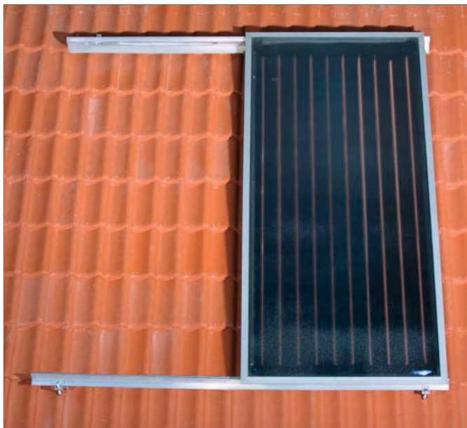
Рис. 3-8 Один смонтированный коллектор из двух
