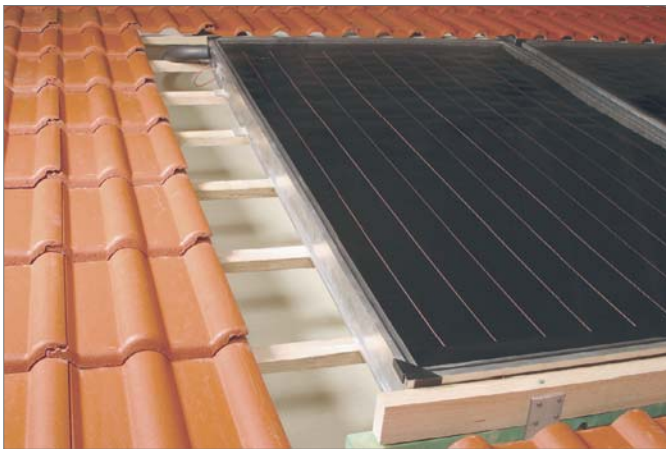
Рис. 3-24 Монтаж в крыше
