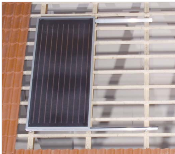
Рис. 3-9 Монтаж в крыше
