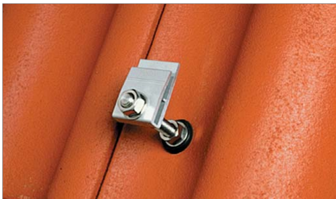
Рис. 3-7 Смонтированный подвесной болт
