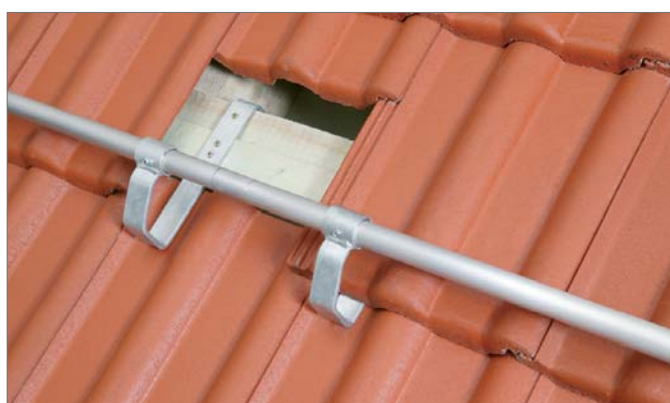
Рис. 3-21 Монтаж на крыше
